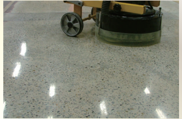
△ レジンボンドパッドによる鏡面仕上げ 【シャインクリート工法】
