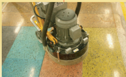
シャインクリート工法 （カラー鏡面仕上げ）
