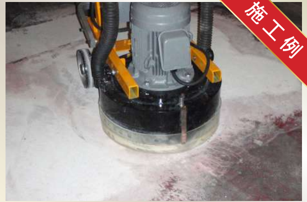
△ スーパーダイヤモンドによるフェロコンの研削
